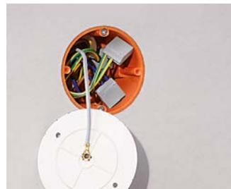
Als Verbindungsdose den Funktionserder des Deckels mit den Beidrähten der Leitungen verbinden.
