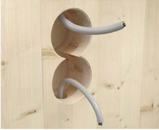
Erstellen der exakten Einbauöffnung  $\varnothing$  74 mm, bei Mehrfachkombinationen im normativen Mittenabstand von 71 mm.
