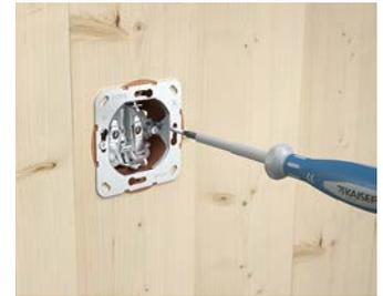
Befestigen des Einbaugeräts mittels Geräteschrauben.
