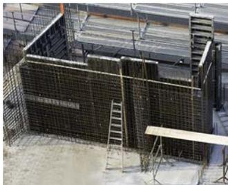
Betonwände können in stehender (vertikaler) oder liegender (horizontaler) Schalung hergestellt werden. Während die liegende Schalung nur eine Schalungsseite hat, gibt es bei der stehenden Schalung die Arbeitsschalung und die Gegenschalung.
