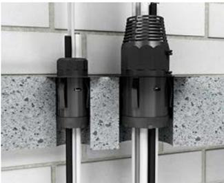
Verwendung in Betondecken EI30-EI90.
