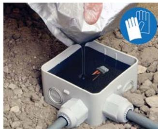
Vergussmasse in den Kabelabzweigkasten einfüllen, Befüllung bis 2 mm unterhalb der Oberkante des Kabelabzweigkastens.
