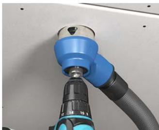
Einbauöffnung mit PROFIL Fräskrone (Art.-Nr. 1081-21) inkl. Staubabsaugung (Art.-Nr. 1088-50) fräsen.
