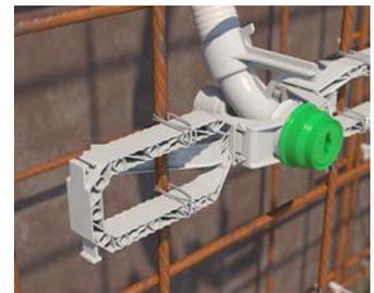
...und die Befestigung mit Rödeldraht an der Bewehrung schnell und sicher mit beiden Händen vornehmen.
