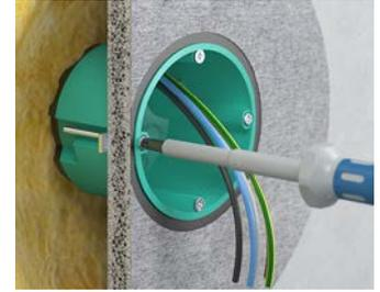
Befestigung der Dose in der Einbauöffnung mittels Laschenbefestigung.
