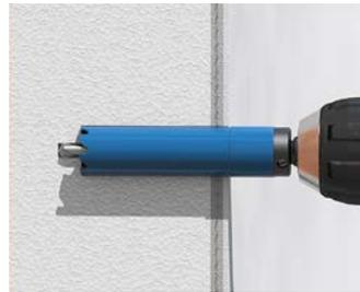
Durch die Bohrtiefenbegrenzung wird nur so viel Dämmmaterial entnommen, wie für die Befestigung des Mini-Geräteträgers benötigt wird.
