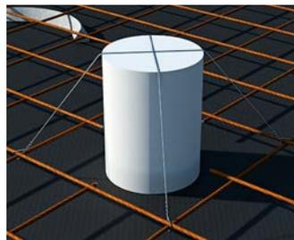
Mit Rödeldraht den Schalungskörper an der Bewehrung fixieren.
