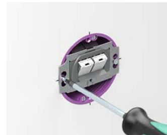
Daten- und Netzwerkleitungen zurück in den Hohlraum der Leichtbauwand führen und das Einbaugerät mittels Geräteschrauben befestigen.
