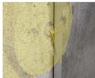
Die Signalborste an den Frontteilen der Flat 45 Systemdosen legt sich beim Abwandern der Schalung an diese an und hält die Position dieser in der Wandoberfläche sichtbar.
