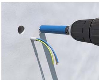
Einbauöffnungen Ø 20 mm mit SPECIAL Fräser mit Tiefenanschlag (Art.-Nr. 1088-06) erstellen.
