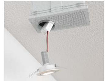
Anbringen der Dämmung und Putz. Montage des LED Einbaustrahlers mit reichlich Raum für das Vorschaltgerät.
