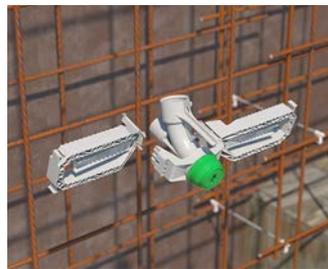
Nun werden die B<sup>1</sup> Prefix®-Systemflügel gemäß der geplanten Betonüberdeckung der Bewehrung an die Prefix®-Wandauslassadapter gesteckt.
