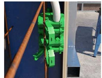
Somit liegen die Rohreinleitungen vor der ersten Bewehrungslage und bleiben ebenfalls uneingeschränkt nutzbar. Die Rohre sind bei nächster Gelegenheit hinter die Bewehrung zu führen.
