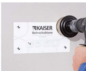
Beiliegende Bohrschablone auf die Wand kleben. Vier Ecken mit Fräser öffnen. Kanten mit Cutter oder Stichsäge ausschneiden.
