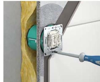
Befestigen des Einbaugeräts mittels Geräteschrauben.
