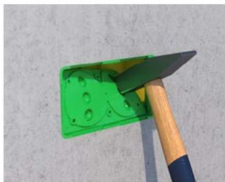
Betonbaudosen öffnen, anschließend Gerät montieren.
