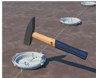
Das flache Frontteil (20 mm) liegt unterhalb der unteren Bewehrungslage, behindert somit die weiteren Folgegewerke nicht und kann anhand der Mittenkennzeichnung exakt ausgerichtet werden.
