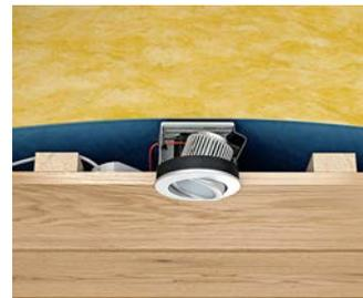
...Paneldecken mit Einfachlattung mit aufliegender Dämmung...
