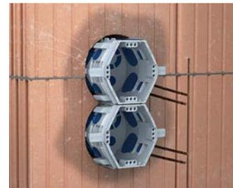
...und die UP<sup>1</sup> Geräte- oder Geräte-Verbindungsdose mit Klemmrippen einsetzen.
