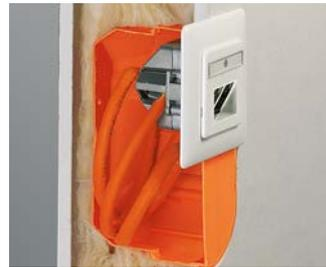
Netzwerkanschlussdosen können unter Einhaltung der Leitungsbiegeradien mit bestmöglicher Datenübertragung betrieben werden.
