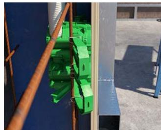
Somit liegen die Rohreinleitungen hinter der ersten Bewehrungslage und aufwändige und destabilisierende Bewehrungsschnitte entfallen.
