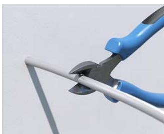
Es ist sicherzustellen, dass die Leitung durch die Dämmstoffplatte geführt wurde. Die vorhandene Leitung auf ca. 10 cm kürzen.
