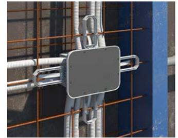
Auch für die Wand geeignet - die Befestigung an der Bewehrung erfolgt mittels Prefix®-Montagetechnik.
