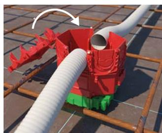
Nach finaler Sichtprüfung der Rohre, lässt sich der Deckel einfach per Handkraft schließen, gleichzeitig wird der sichere Rohrrückhalt hergestellt.
