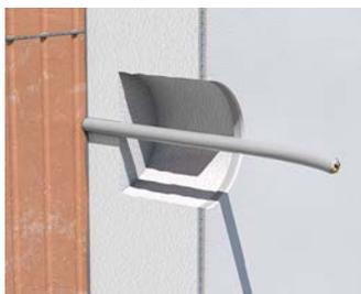
Die Öffnung ist nur so tief wie nötig. Die Dämmung bleibt erhalten und die Leitung unbeschädigt.
