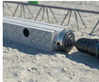
Die seitlichen Einführungen  $\varnothing$  40 mm bis  $\varnothing$  63 mm können mittels Lochsäge ausgebohrt werden.
