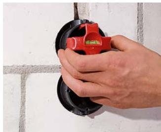
Dosenkombination in die Wandöffnung drücken und ausrichten.
