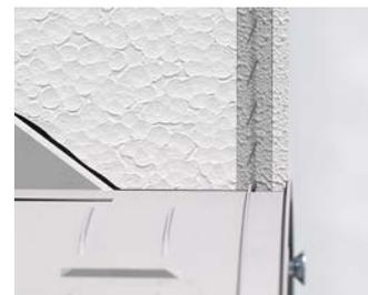
Die umlaufende Dichtlippe dichtet das WDVS ab, so dass keine Feuchtigkeit eindringen kann.
