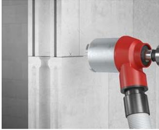
Mit einer Schleifkrone (z. B. Art.-Nr. 1088-02) wird eine  $\varnothing$  82 mm Einbauöffnung erstellt.
