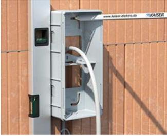
Gehäusesockel lotrecht auf der Wand ausrichten und mit geeignetem Befestigungsmaterial festschrauben.
