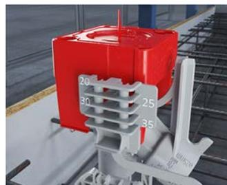
Anhand der Maßskala kann die benötigte Betondeckung schnell abgelesen und exakt eingestellt werden. Die Maßskala ist so abgestimmt, dass die Wand-Deckenübergänge minimal unterhalb der späteren Wandoberfläche liegen...
