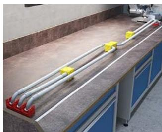
Die geplanten Baugruppen für die jeweiligen Beton- Wandelemente können werkseitig passgenau und termingerecht vorkonfektio- niert...
