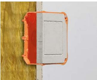
Einbauöffnung anzeichnen und mit einer Stichsäge herstellen.
