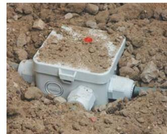
Nach dem Schließen (Deckel und Verschlussstopfen) kann die IP68BOX vergraben und unter Spannung gesetzt werden.
