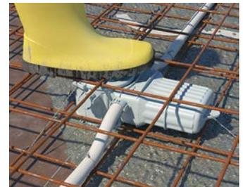
Alle HaloX® Einbaugehäuse sind stabil ausgeführt und werden den rauen Anforderungen auf der Baustelle und im Betonwerk gerecht.
