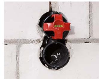
Der perfekte Sitz wird durch die Wasserwaage auf einen Blick angezeigt.
