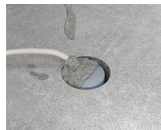
...der freie Raum wird mit Beton aufgefüllt und verdichtet. Das Auslaufen von Beton an der Unterseite verhindert ein untergesetztes Schalbrett.
