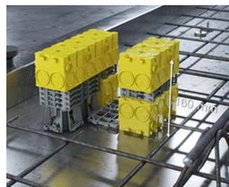
In Kombination mit dem Aufstockelement 10 bis 50 mm (Art.-Nr. 1261-10) und den Universal-Aufstockelementen 105 - 170 mm (Art.-Nr. 1261-08)...
