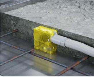
Der System-Haftmagnet dient zur Aufnahme von B<sup>2</sup> Geräte-Verbindungsboxen,...
