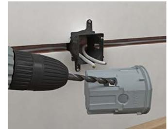
Passgenaue und luftdichte Leitungseinführung mit Bohrer erstellen.
