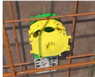
Sind alle benötigten Rohreinführöffnungen erstellt, kann der rückseitige Deckel geschlossen werden.
