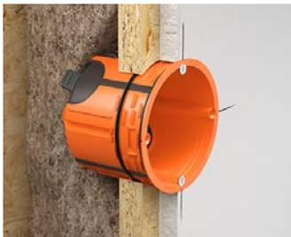
Wandaufbau OSB-Platte mit Gipskarton.
