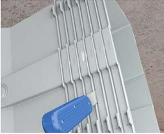
Einbaugehäuse an die gemessene Dämmstärke anpassen.
