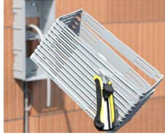
Aufstockelement ggf. an die Dämmstärke anpassen.
