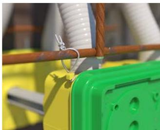
In Erwartung extremer Belastungen sorgen Rödellaschen für die zusätzliche Sicherung.
