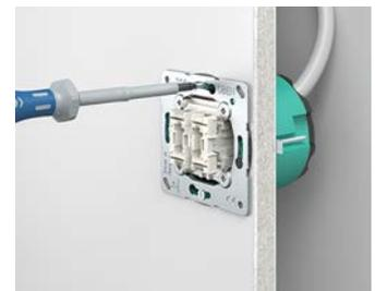
Einbaugerät mittels Geräteschrauben befestigen.
