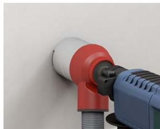
Bei Dämmstärken < 100 mm Wandöffnung erstellen (Ø 82 mm).
