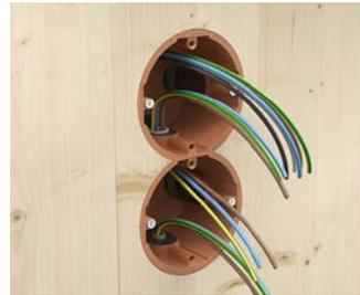
Anschließend werden die Verbindungsleiter durch den Verbindungsstutzen geführt.
