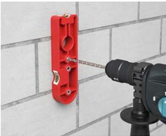
Vorbohren. Für Mehrfach-dosen mit Bohrschablone Zentrierbohrung im Kombina-tionsabstand herstellen.
