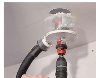
Sobald das Material durchtrennt ist, Bohrmaschine sofort ausschalten. Erst nach Stillstand den VARIOCUT zurückziehen und das ausgeschnittene Material entfernen.
