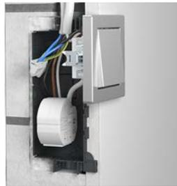
Hier z. B. ein Relais für die zentrale Steuerung mehrerer Jalousie-Antriebe oder eine EIB-Unterputz-Schnittstelle mit einem konventionellen Taster.
