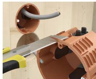
Bei Mehrfachkombinationen im normativen Mittenabstand von 71 mm wird der Halterand einfach geschnitten (z. B. mittels Cuttermesser).
