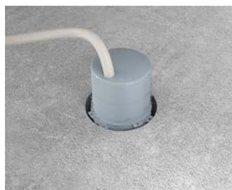
Das komplette Gehäuse mit eingebrachtem Installationsrohr wird nun in die Ausparung bzw. Kernbohrung eingesetzt und auch...
