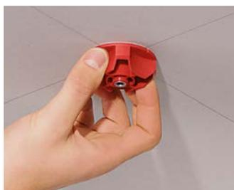
Mittelpunkt der Bohrung anzeichnen (ggf. Schneidzentrierer verwenden). Passende Drehzahl an der Bohrmaschine einstellen. Bleche vor dem Fräsen mit Ø 6 mm vorbohren.
