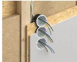
...in einer F60-B Wand sind Einzeldosen bis zu einer 3-fach Kombination möglich.
