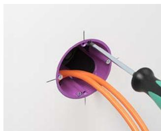
Die Geräte-Anschlussdose O-range ECON® Data in die Einbauöffnung setzen, anhand der Mittenkennzeichnung ausrichten und die Laschenschrauben anziehen.
