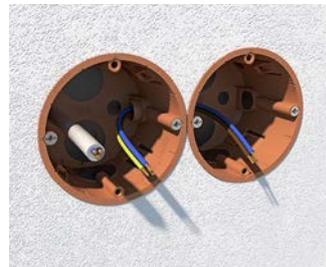
Nach dem Abziehen der Öffnungslaschen und Einsetzen des Verbindungsstutzens erfolgt die Durchverdrahtung.
