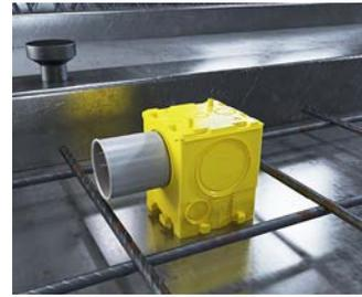
Die Rohrkupplung wird mit Druck gegen die Geräte-Verbindungsdose gedreht bis die Durchführung ausgeschnitten ist.
