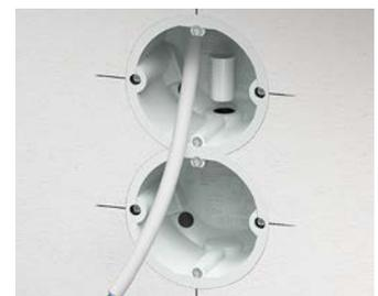
Die vollisolierte Durchverdrahtung von Geräte-Verbindungs-dosen untereinander erfolgt mit dem Verbindungsstutzen (Art.-Nr. 9060-78).
