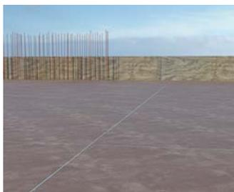
Die genaue Position der Deckendosen erfolgt mittels Schnursschlag oder spannen einer Maurerschnur.
