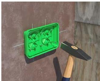
Frontteil an der Schalung befestigen (Nagel- oder Schraubenbefestigung).
