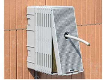
Montageplatte aufsetzen (Verschlussclip unten) und verschließen.
