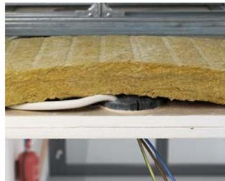
Mit Mineralwolle nach EN 13501 Teil 1 hält die Installation einem Brand bis zur Feuerwiderstandsklasse F60 (EI60) stand, mit Rockwool/ Termarock 100 bis zur Feuerwiderstandsklasse F90 (EI90).
