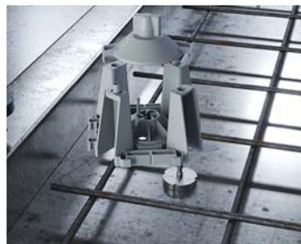
...die System-Haftmagnete (Art.-Nr. 1299-69 oder 1299-70) und bietet somit die exakt ausgerichtete und sichere Basis für die obenliegende Installation.
