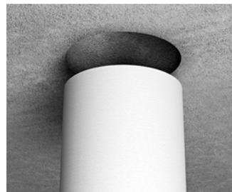
Nach dem Entschalen den Schalungskörper rückstandslos aus der Bauteilöffnung entfernen.
