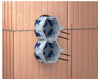
UP<sup>1</sup> Geräte- oder Geräte-Verbindungs-dose mit Klemmrippen einsetzen.
