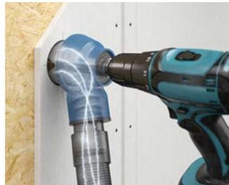
Die Verwendung der Absaugung verhindert das Freisetzen gesundheitsgefährdender Stäube und erhöht die Lebensdauer der Fräskrone.
