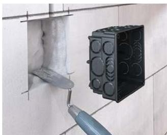
Stellen Sie eine passende Wandöffnung her, führen die Leitungen und Rohre in das Gehäuse und fixieren dieses (mit Gips) in der Wand.
