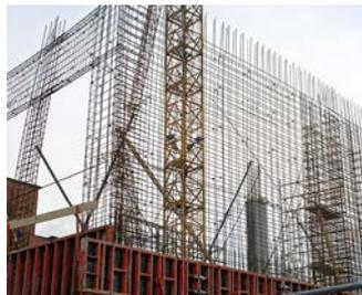
Gleitende bzw. wandernde Schalungen werden vertikal zur Fertigung von Bauwerken mit großen Höhen und horizontal z. B. für Fahrbahndecken und Betonschutzwände eingesetzt.
