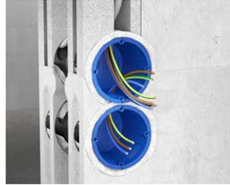
Die schalldichte und voll-isolierte Durchverdrahtung erfolgt durch den Verbindungsstutzen.
