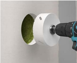
Einbauöffnung mit Ø 120 mm BASIC Fräser (Art.-Nr. 1084-20) erstellen.
