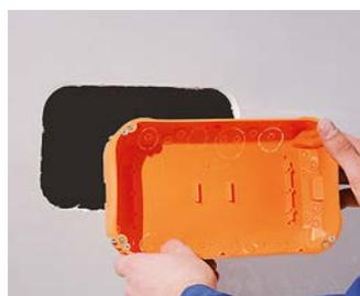
Einführungen ausbrechen, Leitungen einführen, Kasten einsetzen und mit den FX<sup>4</sup>-Schrauben befestigen.
