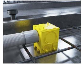
Die Rohrkupplung wird einrasten und das Rohr in die Durchführung eingeführt.
