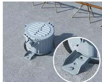
Gehäuse aufstecken und in die Kernbohrung setzen, anzeichnen und befestigen. Rohr in Kombinationseinführung M20/M25 installieren.
