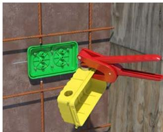
Rohreinführung herstellen (Stanzzange oder Universal-Öffnungsschneider).
