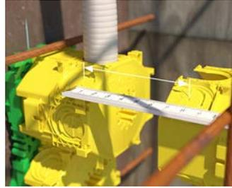
Anschließend kann die benötigte Stützelementlänge einfach an den dafür vorgesehenen Markierungen an der B<sup>1</sup> Gerätedose gemessen und anschließen abgesägt werden.
