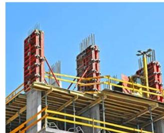
Durch das langsame Gleiten bzw. Wandern der Schalung wird ein stetiger Baufortschritt sichergestellt.
