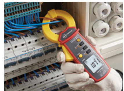
Differenzstrommessung mit Leckstromzange
