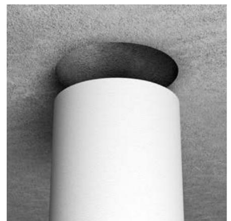
Nach dem Entschalen den Schalungskörper rückstandslos aus der Bauteilöffnung entfernen.
