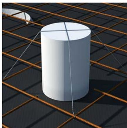
Mit Rödeldraht den Schalungskörper an der Bewehrung fixieren.
